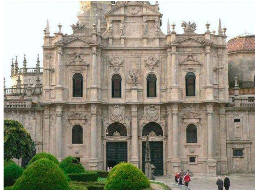
Después de tratamiento con G200 ÓXIDO
