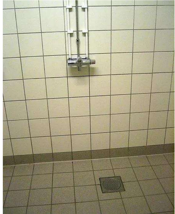
Después de tratamiento con G200 ÓXIDO
