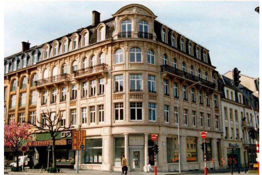
Después de tratamiento con G200 ÓXIDO
