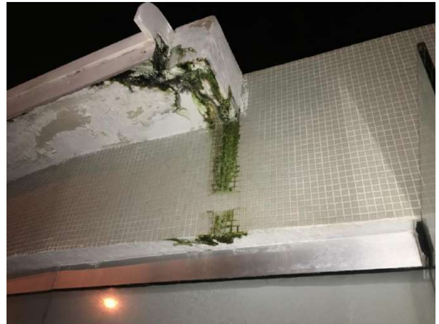
Después de tratamiento con G200 ÓXIDO
