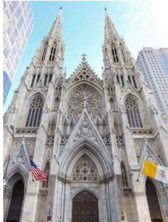
Después de tratamiento con G200 ÓXIDO
